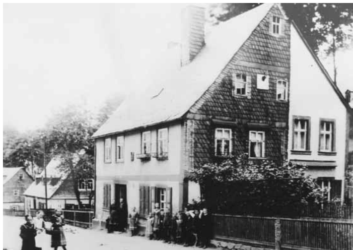
1901 Wohn- und Geschäftshaus der Fam. Franz Ströher - die beiden linken Häuser gehörten dazu - ganz rechts Karl Ströher
