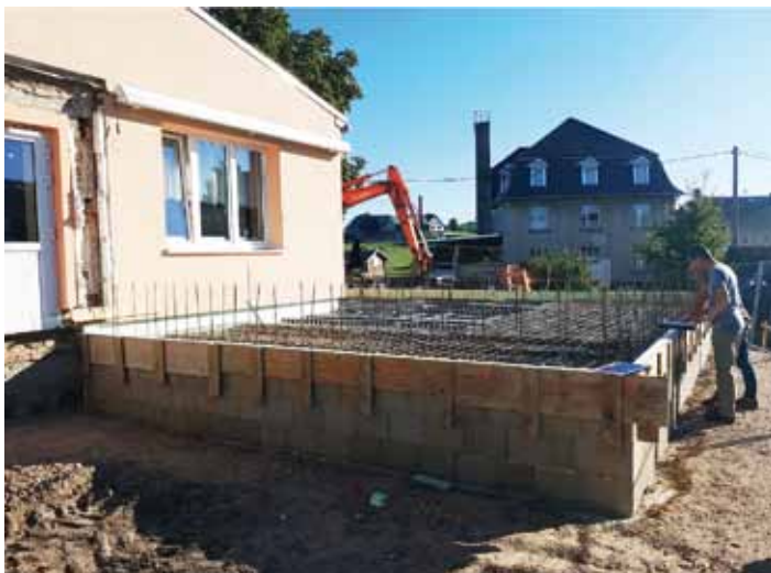
Architekt M. Bärthel bei der Bewehrungsabnahme Foto: A. Gruner
