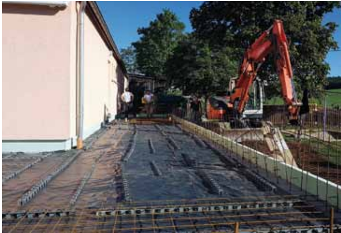
Einbringen der Bewehrung im hinteren Teil des Anbaus Foto: A. Gruner
